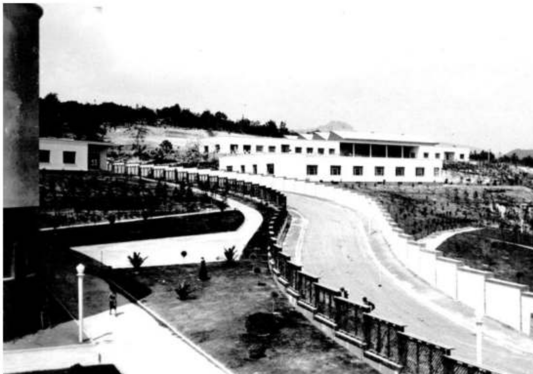
La doppia murazione che divideva il settore femminile dal maschile, lungo la strada panoramica di risalita
